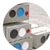
Блоки инженерных коммуникаций, подготовленные к установке
